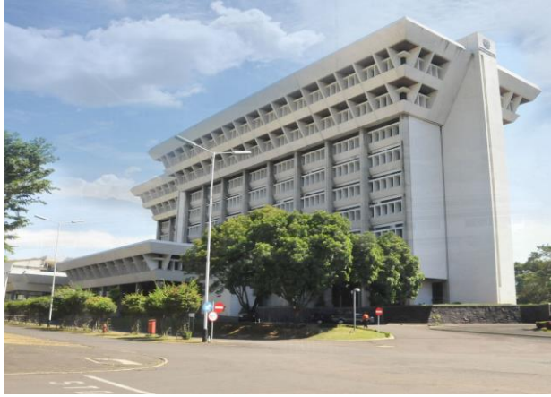
Gambar 3. Gedung Lokasi Kerja Praktek
