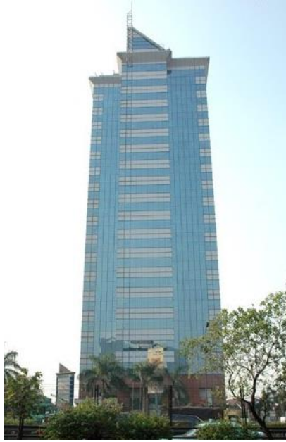
Gambar 2.4 Gedung Lokasi Kerja Praktek
