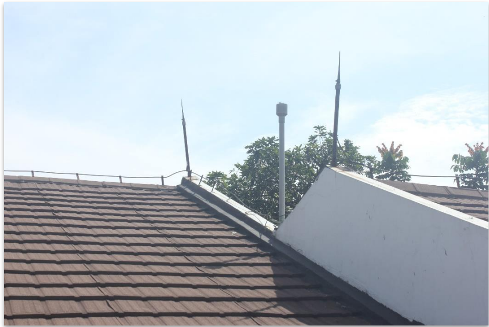
Gambar 32. Kondisi antenna setelah perbaikan
