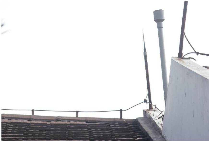
Gambar 27. Kondisi Antena diambil dari sebelah timur
