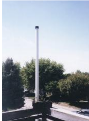
Gambar 13. Contoh pemasangan antenna (sensor)
