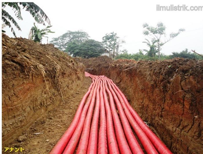
Gambar 3.7 Saluran Kabel Tegangan Menengah
