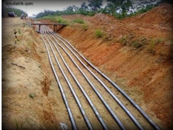
Gambar 3.5 Saluran Kabel Tegangan Tinggi
