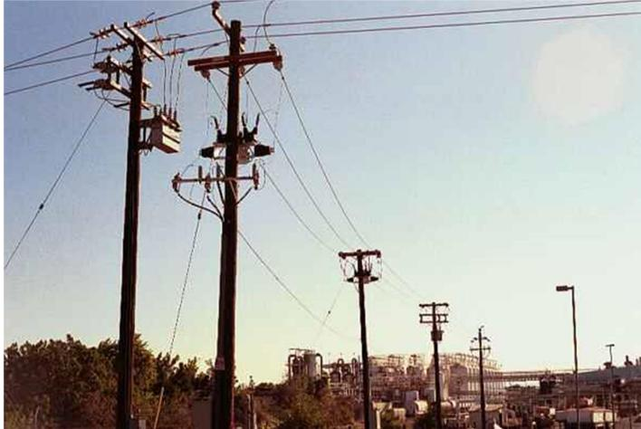
Gambar 3.6 Saluran Udara Tegangan Menengah
